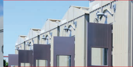
Conoco Phillips EHT Rooms
